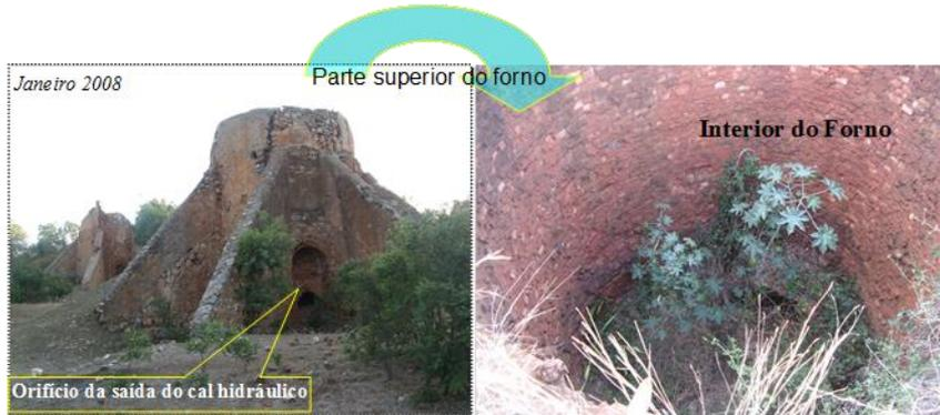
Foto-1 Aspecto actual do forno de cal hidráulico na Tchibia, construída na década 50
